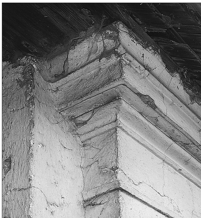
Obr. 34: Sádek čp. 33 – detail římsy ve východním průčelí stodoly, vedle vjezdu do levé části (kolny).
