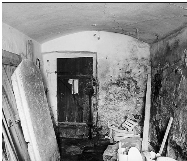
Obr. 11: Sádek čp. 33 – komora u západního nároží domu, zastropená segmentovou klenbou z poslední čtvrtiny 19. století.
