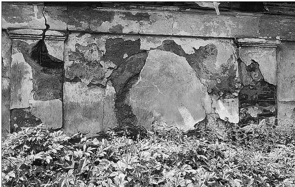
Obr. 26: Sádek čp. 33 – část jihovýchodního průčelí chléva v jihovýchodním křídle se zazděným oknem a do- datečně zaplentanou vpadlinou.
