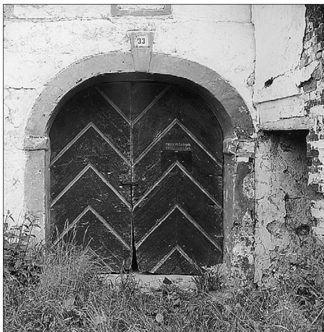
Obr. 24: Sádek čp. 33 – vjezd do síně v severovýchodním průčelí, upravo mladší přístavek z 80. let 19. století.
