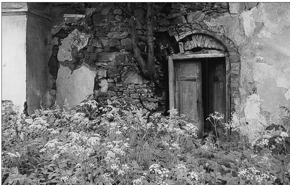
Obr. 25: Sádek čp. 33 – fragment pravděpodobně barokního zdiva v části jihovýchodního průčelí jihovýchodního křídla mezi domem a mladšími chlévy z 50. let 19. století.
