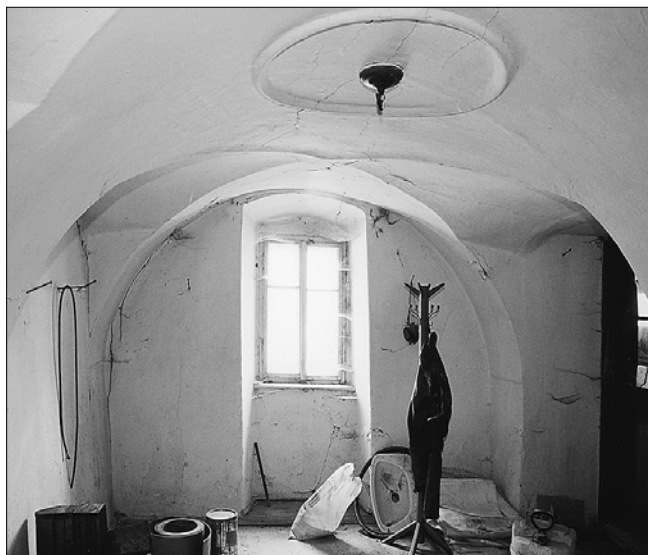
Obr. 10: Sádek čp. 33 – světnička v druhém traktu přízemí, domu zastropená mladší klasicistní klenbou se styčnými výsečemi, zvýrazněnými vytaženými hranami a jednoduchým štukovým zrcadlem.
