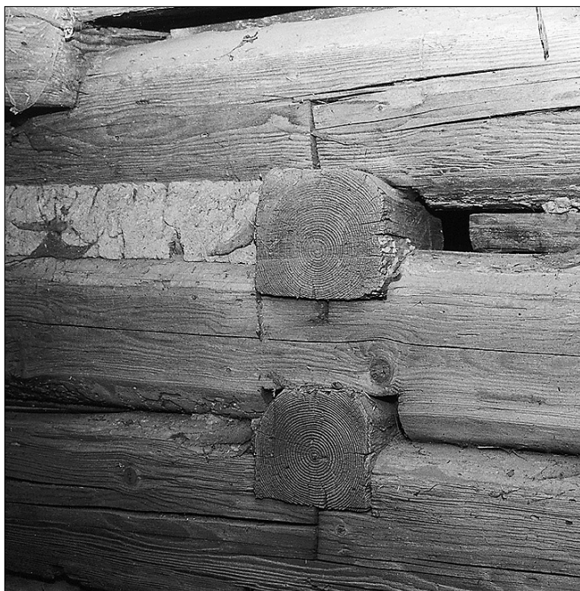
Obr. 21: Sádek čp. 33 – detail jihozápadní stěny komory s naříznutými trámy a distančními vložkami.
