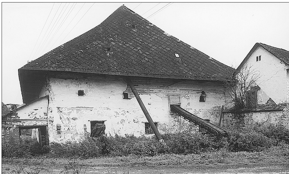
Obr. 4: Sádek čp. 33 – celkový pohled na dům od severu.
