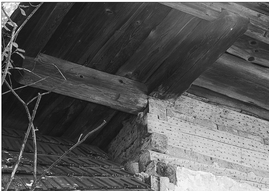
Obr. 19: Sádek čp. 33 – jižní nároží domu.
