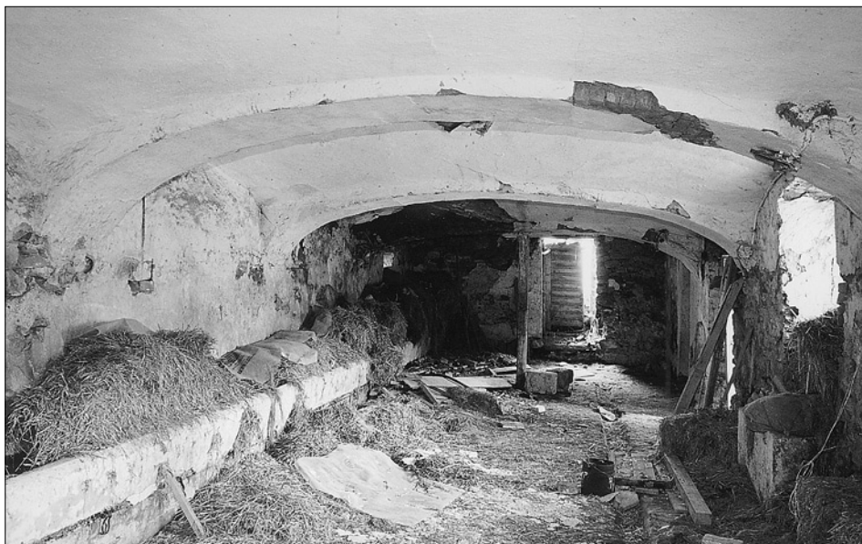
Obr. 27: Sádek čp. 33 – chlév v jihovýchodním křídle, postavený v 50. letech 19. století.
