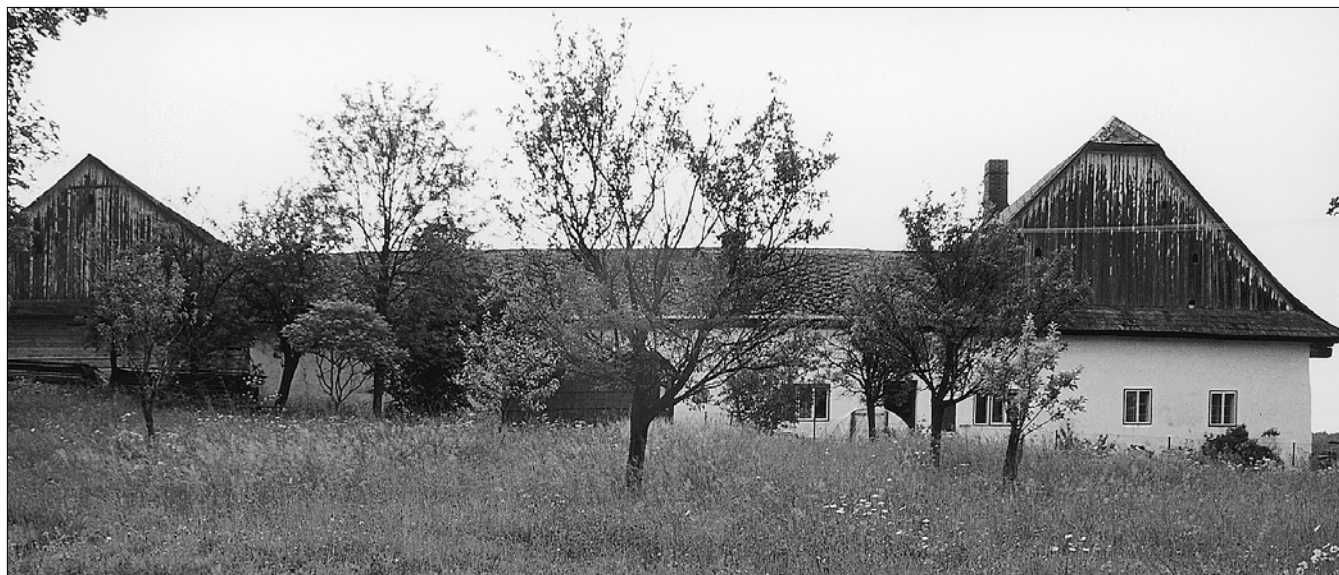
Obr. 28: Sádek čp. 26 – celkový pohled.
