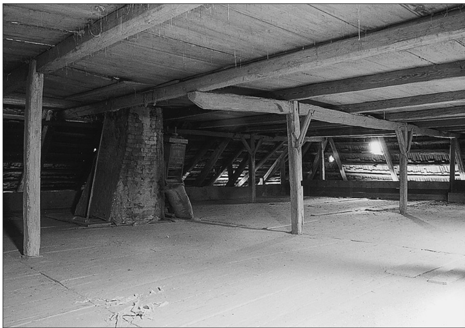
Obr. 23: Sádek čp. 33 – jihovýchodní část krovu s dodatečně (?) vloženými vaznicemi pod spodní hambalky.
