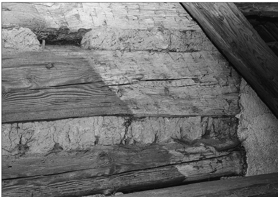
Obr. 20: Sádek čp. 33 – jihozápadní průčelí patra domu u jižního nároží se stopou po starší poloze střechy jihoovýchodního křídla (před 1854).
