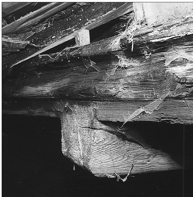
Obr. 22: Sádek čp. 33 – detail profilované okapové vaznice nad pavlačí v jihozápadním průčelí domu.
