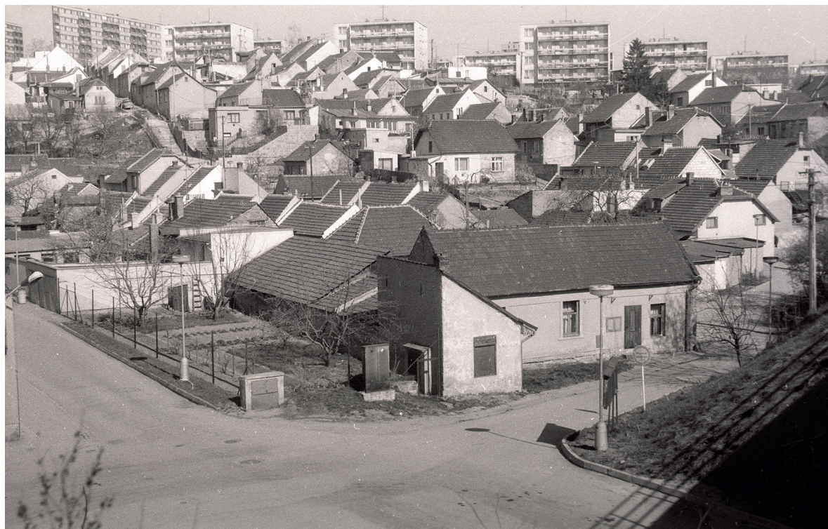
6 – Z průzkumu památkového potenciálu Brna: Divišova kolonie pod sídlištěm Lesná, duben 1988.
