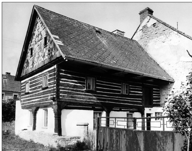
Obr. 19: Loubí, dům usedlosti čp. 10, u kterého se podařilo požár roku 1843 zastavit a jehož přední obytná část se dodnes dochovala ve starší roubené výstavbě. Stavba je datována letopočtem 1807 na podstavce ve štítovém průčelí, zadní část domu byla přestavěna ve 3. čtvrtině 19. století.
