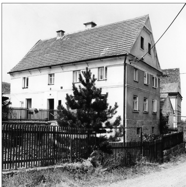
Obr. 13: Louboř, dnešní stav chalup čp. 5 a 6, situovaných při znovuvýstavbě podle regulačního plánu z roku 1843 v severním čele návsi. V popředí objekt čp. 5, postavený zřejmě hned s výraznými diferencemi oproti projektu: stavba je patrová, s hospodářským prostorem pod světnicí v suterénu, který využil umístění domu na terénní hraně. Vzadu rovněž patrová chalupa čp. 6.
