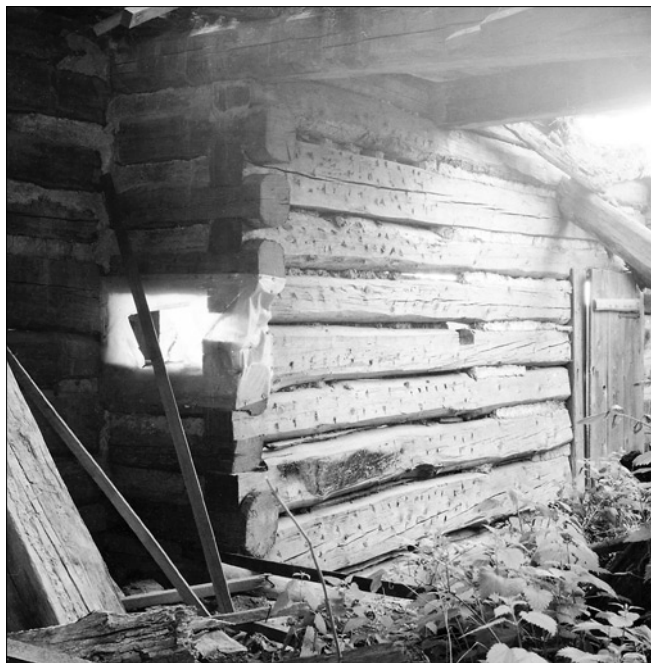
Obr. 25: Loubí, otisk někdejšího dřevohlíněného provedení komína nad hlavním topeništěm na roubené stěně síně v patře domu čp. 46. Konstrukce komína, resp. dole otevřeného dymníku byla kombinovaná - vlevo jsou u nároží odřezány trámy jeho roubené stěny, stopy po zatlučení kolíků vymezují jeho vnitřek z hlíněnou vymazávkou a uprostřed šikmého vymezení této plochy vpravo je dlab po zakotvení trámu jeho protější stěny, která tudíž musela být hrázdná.
