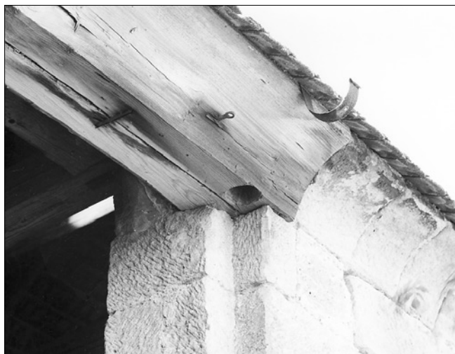
Obr. 32.: Loubí, detail dřevěné fabionové římsy a stejně tvarovaného dřevěného překladu vrat stodoly v usedlosti čp. 51.
