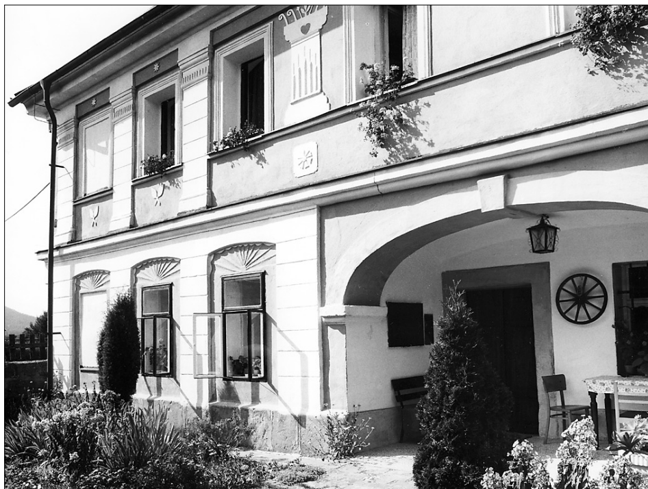
Obr. 14: Loubí, ztvárnění vstupního průčelí domu malé usedlosti čp. 7, stavěného po požáru roku 1843. Vstup do domu a komunikace ke chlévu jsou chráněny dvojicí arkád, klasicistní štuková výzdoba užívá motivy, obvyklé i v jiných částech Čech. Zajímavý je výrazný motiv vázy s klíčovými rostlinami (chmel?) v patře.
