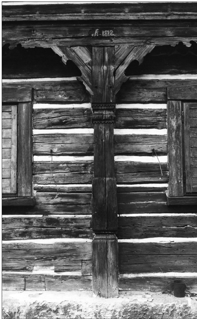
Obr. 23: Loubí, detail podstávky domu usedlosti čp. 43 západně od jádra vesnice, s datováním 1812 nad sloupkem.
