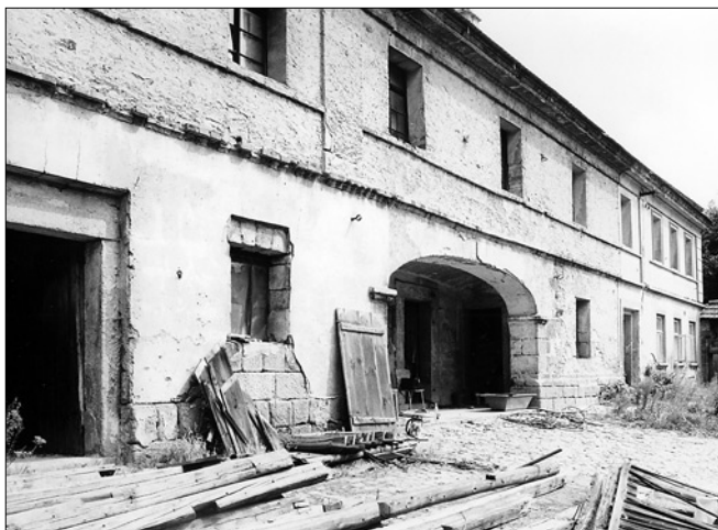
Obr. 26: Loubí, jednoduché pozdně klasicistní ztvárnění bočního průčelí druhého, mladšího zděného domu v usedlosti čp. 46 z doby po polovině 19. století, dochovaného s řadou cenných detailů v interiéru.
