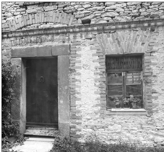
Obr. 35: Loubí, vstup ve dvorním průčelí domu čp. 60 (na návsi, mezi čp. 51 a 1). Materiálové i konstrukční provedení a také ponechání v neomítnutném stavu je v regionu typické pro vesnickou stavební tvorbu 2. poloviny 19. století (všechny fotografie P. Dostál a J. Škabrada 1993 - 95).
