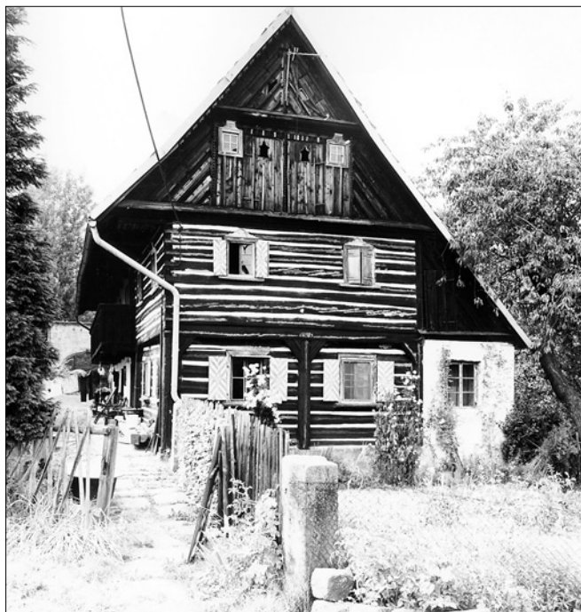
Obr. 34 Loubí, převážně dřevěný dům čp. 57 západně od jádra vesnice, postavený na počátku 19. století, s cennými prvky původního řemeslného zpracování (bedněný štít, pavlač, malované okenice).
