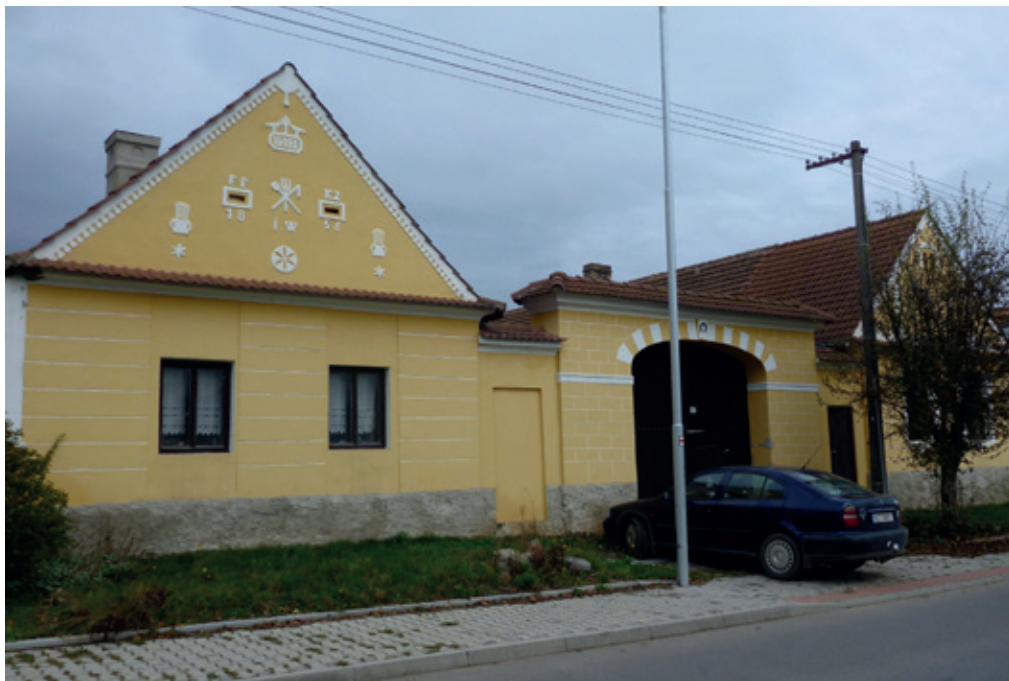
Dolní Slověnice čp. 19 a 54 (výměnek)
