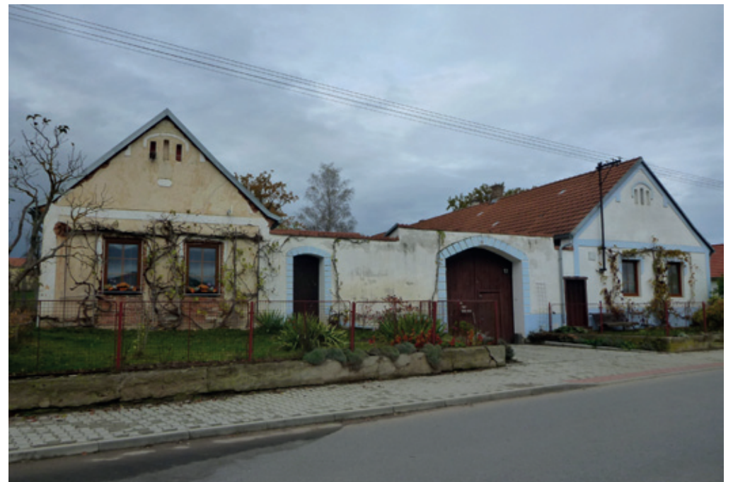
Dolní Slověnice čp. 17 a 49 (výměnek)
