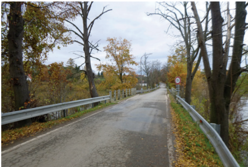
Trojmostí; celkový pohled na příjezdu od Dolních Slověnic; v popředí most č. 148-005.
