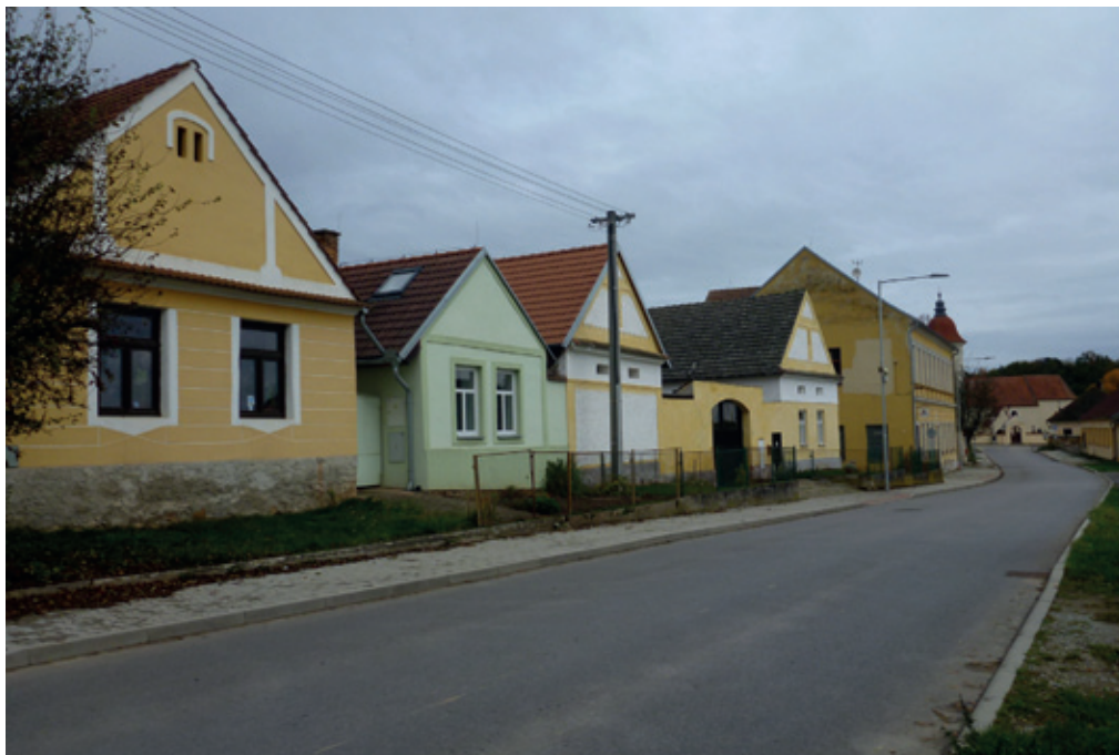
Dolní Slověnice pohled od čp. 19 ke kostelu
