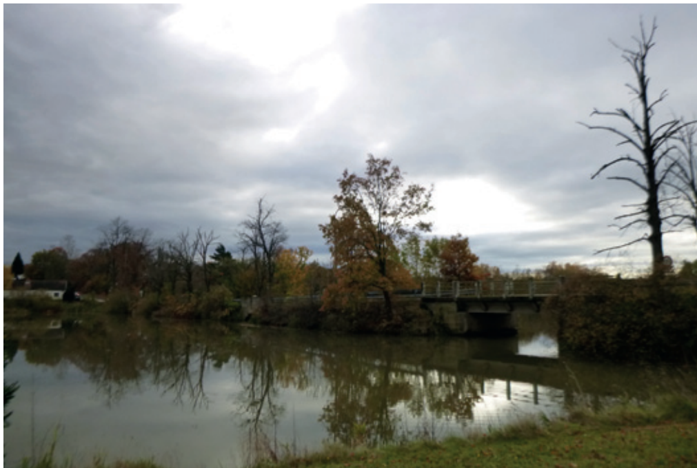
Trojmostí; celkový pohled od Dolních Slověnic; vpravo most č. 148-005.
