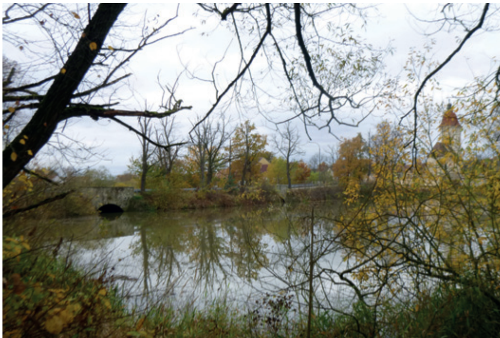
Trojmostí; celkový pohled od Horních Slověnic; vlevo most č. 148-007.
