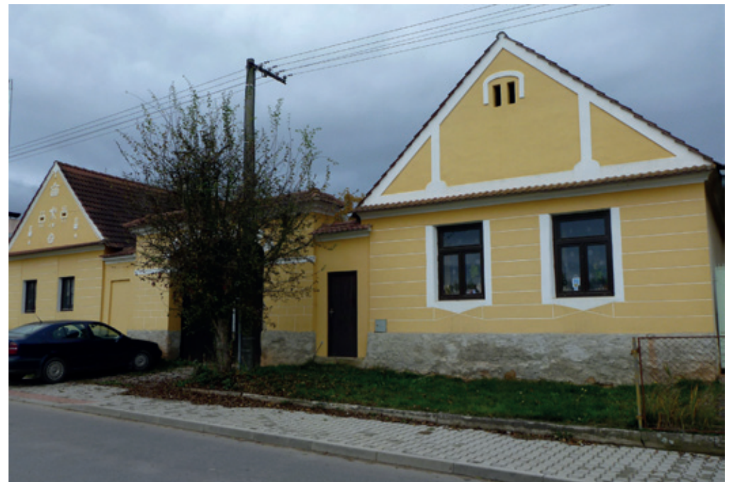
Dolní Slověnice čp. 19 a 54 (výměnek)
