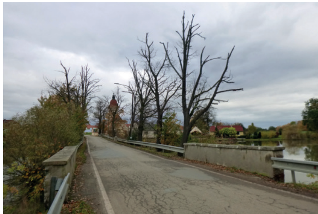
Celkový pohled na příjezdu od Horních Slověnic; v popředí most č. 148-007.
