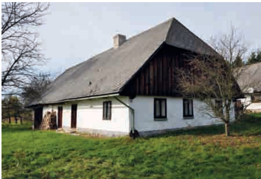
← Nepomuk na Rožmitálsku, dům čp. 22 se širokou „šumavskou“ polovalbovou střechou (JP 2013).
