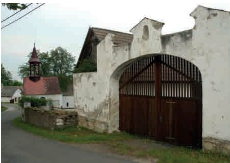
← Cunkov, průčelí usedlosti čp. 1 se zajímavě řešenou bránou (JP 2007).
