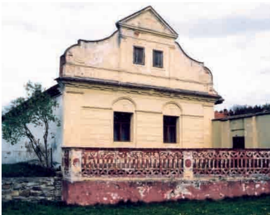
← Podeřístě, dům čp. 16 a Zaliny, usedlost čp. 25: obě stavby, geograficky značně vzdálené, představují krajní výspy klasického blatského stylu, navíc v mimořádně čisté architektonické podobě (JP 2001).
