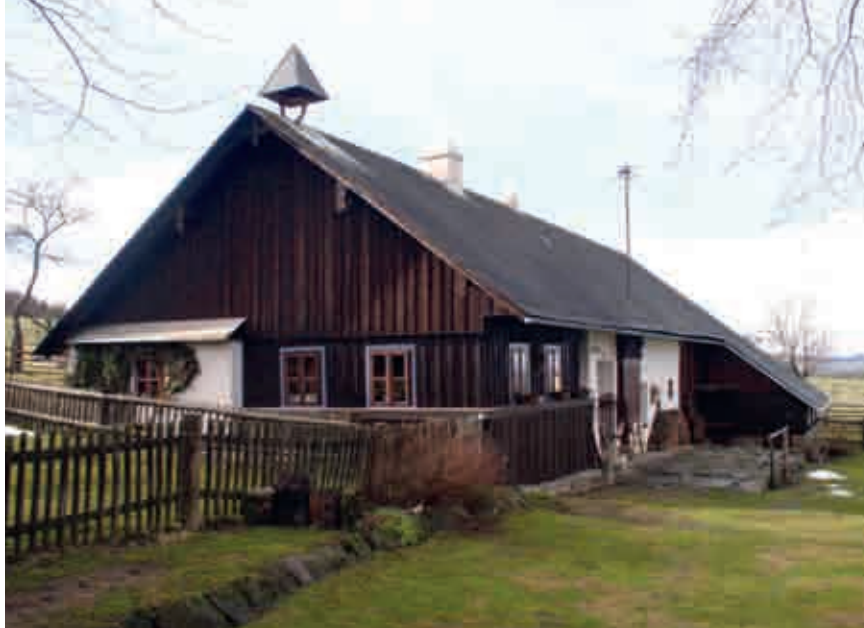
← Hořejší Těšov, dům čp. 9 s roubenou obedněnou světnicí, druhotným nízkým vaznicovým krovem a zvoničkou v podobě rozsochy v hřebeni střechy (JP 2004).
