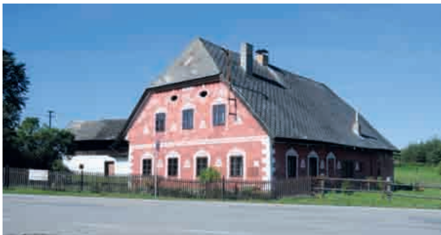
← Blažejovice, dům čp. 48 s ojedinělou výzdobou průčelí (KK 2017).
