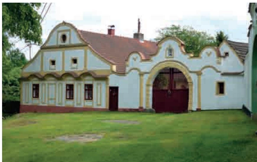
← Zahrádka poblíž Kostelce nad Vltavou, usedlost čp. 6 s bohatě řešeným průčelím (KK 2015).
