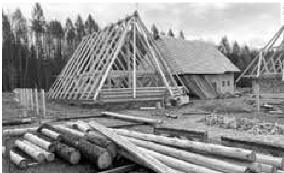
STAVBA NOVÉHO ARCHEOSKANZENU TROCNOV V AREÁLU PAMÁTNÍKU JANA ŽIŽKY Z TROCNOVA JE PROVÁZÁNA S PROJEKTEM I-CULT A MĚLA BY BÝT DOKONČENA V ROCE 2024.
